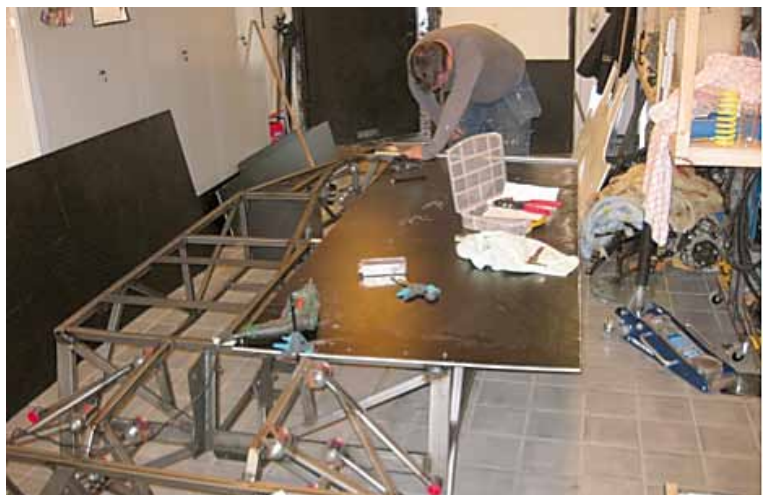
Konstruktion av golv
